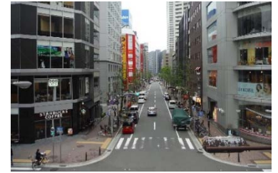
整備前の葺合南 54 号線
