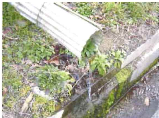
地下水が水路を通して池に入っている
