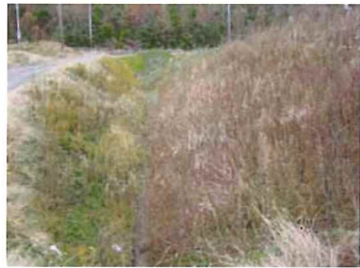
管理が大変な水路の法面
