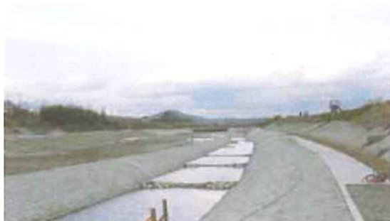
自然工法を取り入れた河川改修
