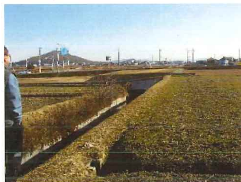
ほ場整備によりできた水路
