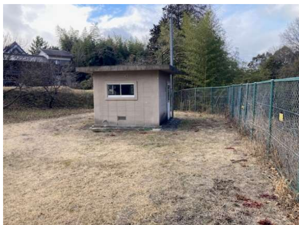
ゴム堰操作室
