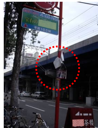
消火栓標識 (はり紙)
