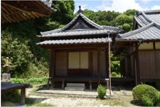
本堂（南面屋根は入母屋）
