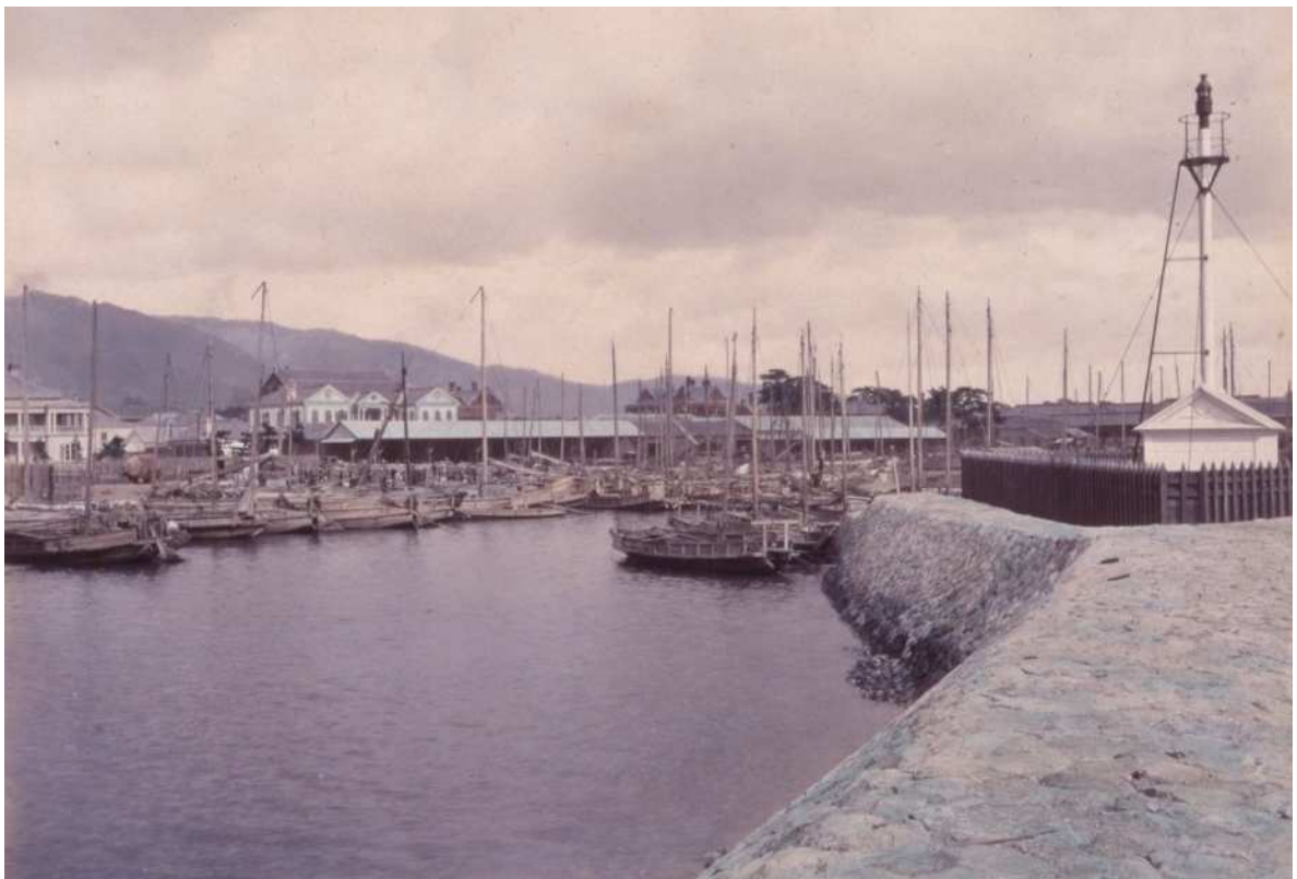
明治時代中期の神戸港第一波止場の様子 『瀬戸内海写真帳』神戸市立博物館蔵 写真右端に石積の防波堤上に燈竿（とうかん）を立てた灯台施設が見える
