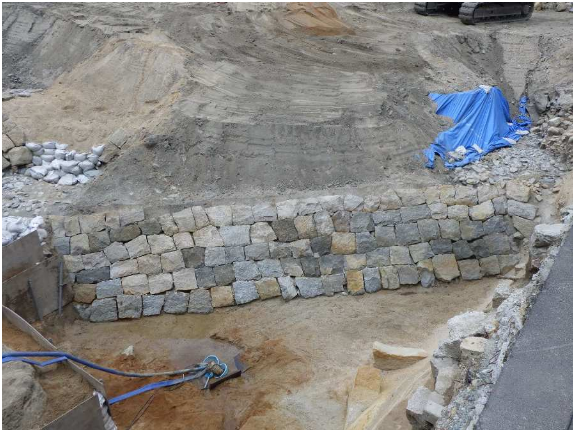
第1期（江戸時代末期） 海軍操練所に伴う防波堤（現地保存された遺構）（南から）
