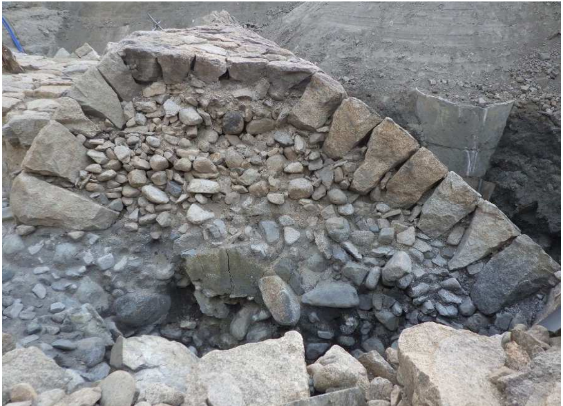
神戸港第一波止場 石積防波堤の断面（現地保存された遺構）（東から） 初期神戸港の防波堤の構造・構築技術・構築過程が分かる遺構
