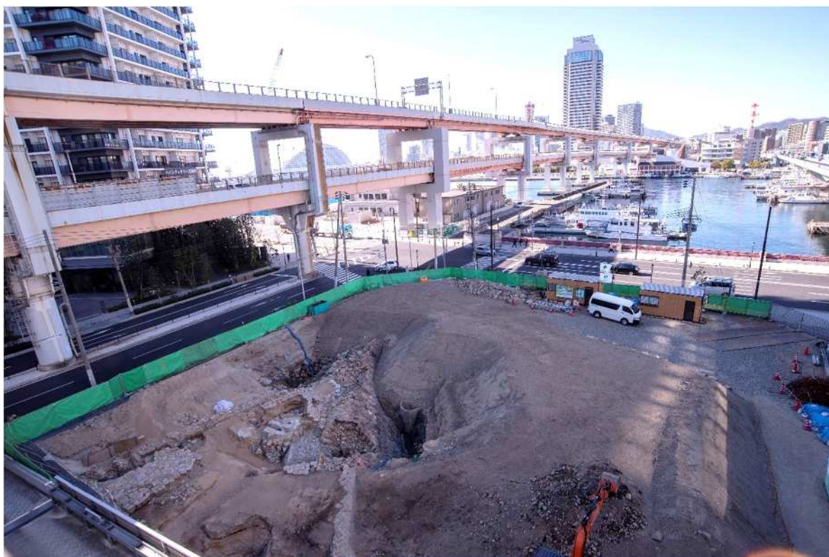
発掘調査現場（手前）と神戸港（新港）方面を望む（北東から）
