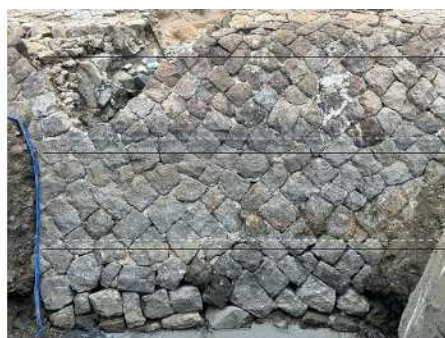
中央トレンチ北側防波堤北面(写真)
