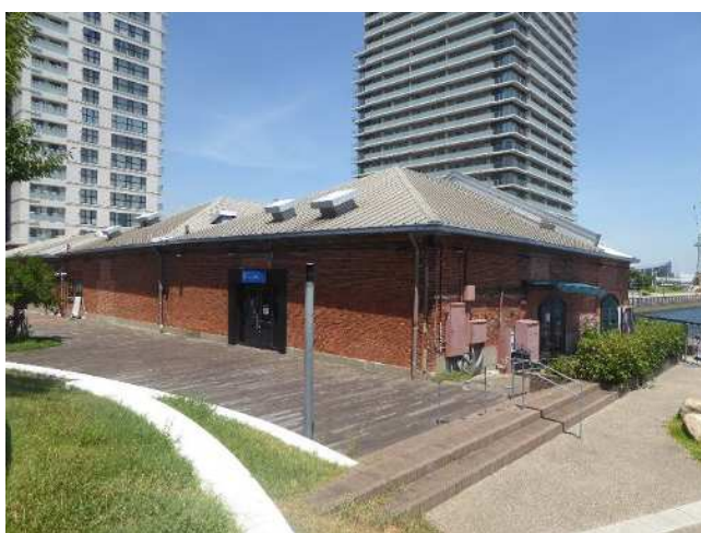
9. 南棟西～南面(南西から)
