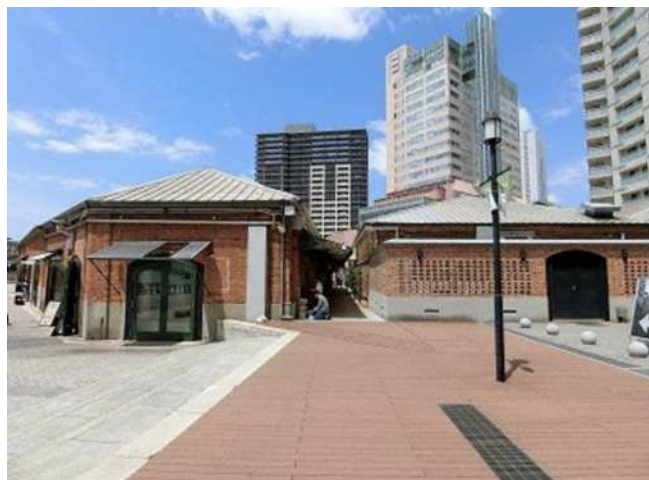
2. 北棟と南棟(東から)
