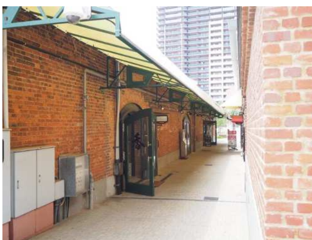
5. 2棟間の路地(東から)
