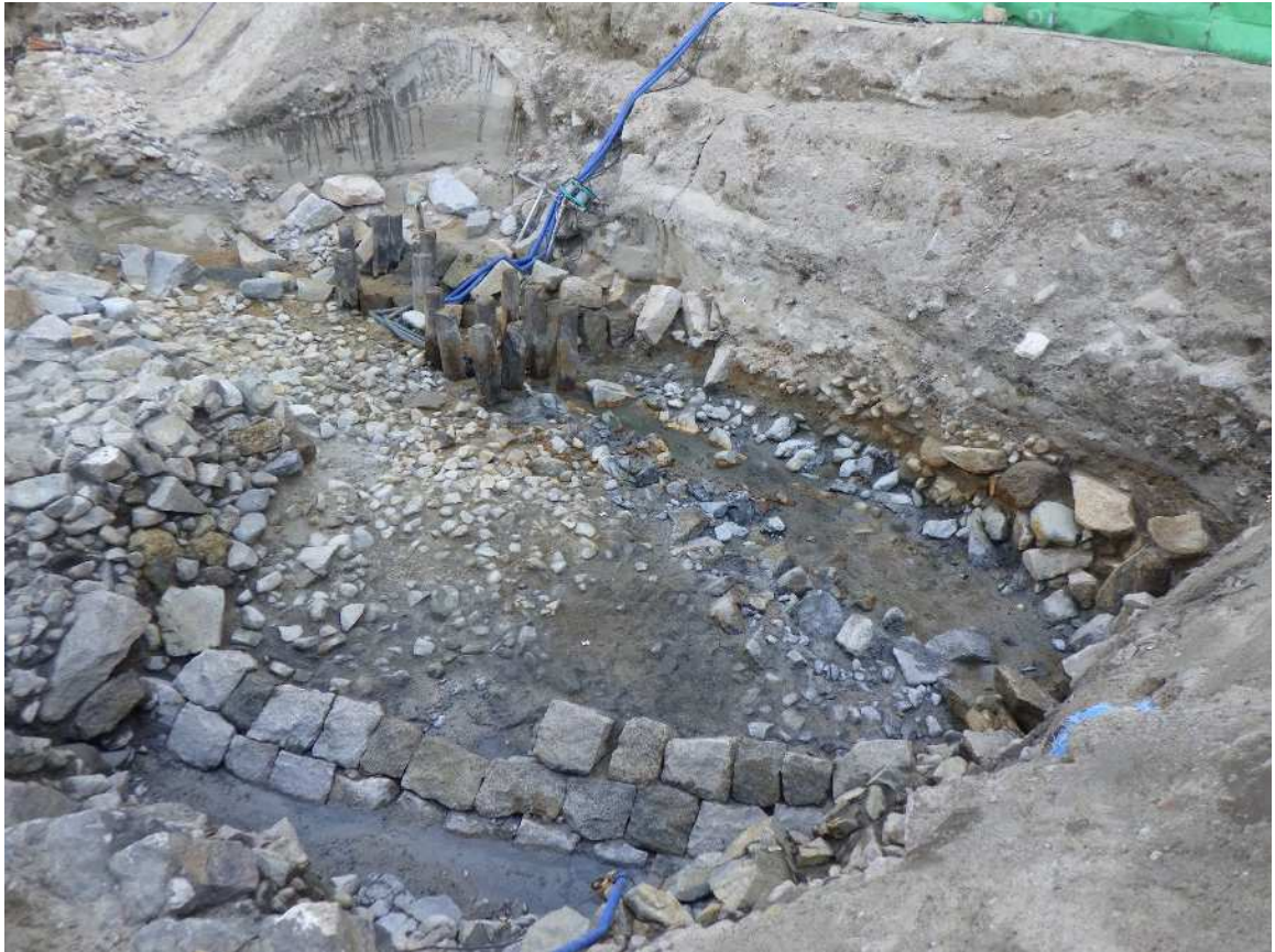
江戸時代末期の海軍操練所に伴う防波堤（現地保存された遺構）（西から）
