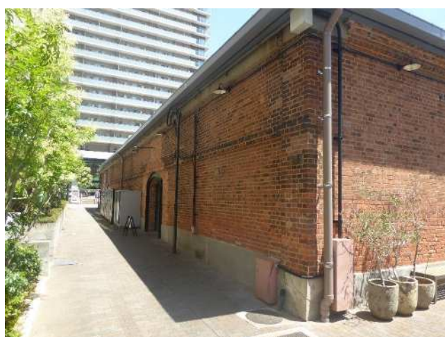
4. 北棟北面(北西から)
