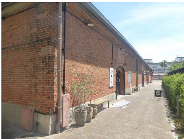
3. 北棟西面(北西から)
