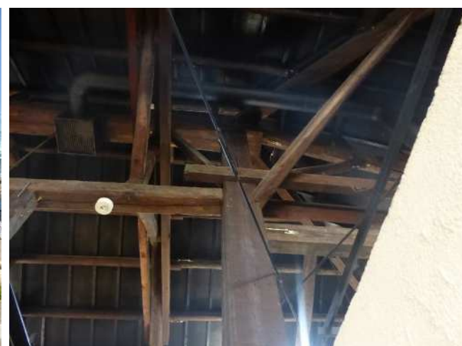
10. 南棟小屋組(部分)
