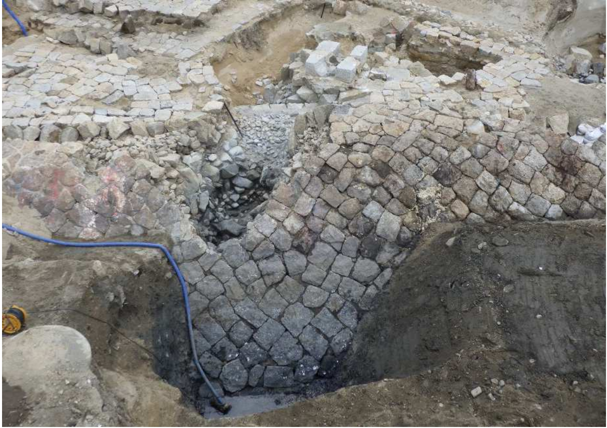
神戸港第一波止場の石積防波堤の遺構（現地保存された遺構）（北東から）
