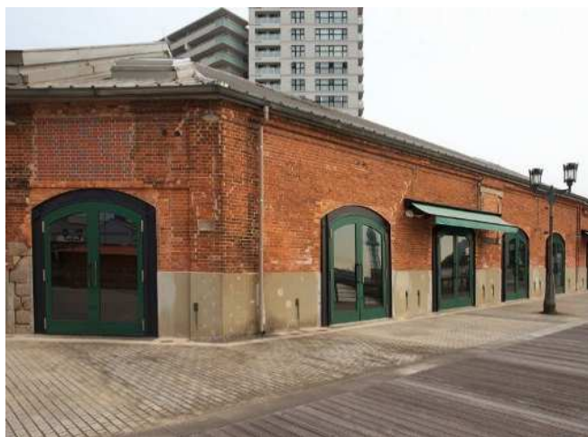
8. 南棟東面(南から)
