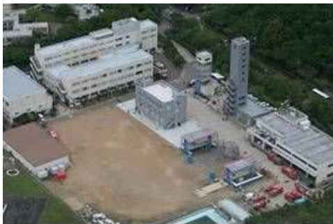
市民防災総合センター
