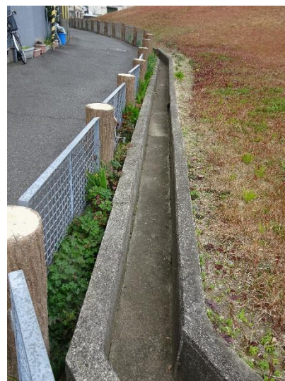
小壺古墳 側溝
