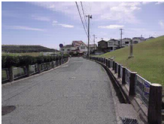
アスファルト舗装
