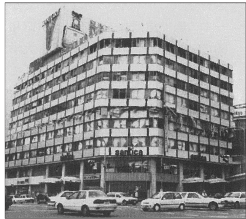
▲阪神・淡路大震災当時の中央区 5階部分が押しつぶされた神戸交通センタービル
