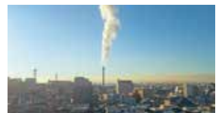
稼働した石炭火力発電所の煙突
