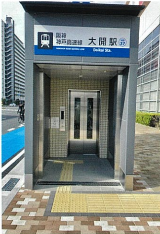
完成した大開駅 エレベーター
