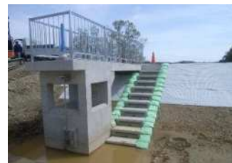
ため池改修工
