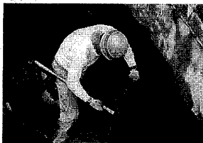
写真4 応急復旧工事
